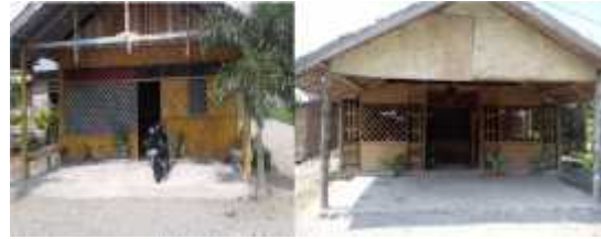
Gambar 11. Salah satu rumah berbahan konstruksi dari Bambu
