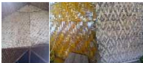
Gambar 14. Ayaman Bambu untuk dinding rumah
