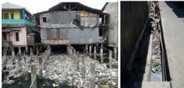
Gambar 10. kondisi Drainase pada kawasan Permukiman (sumber: analisis penulis, 2018)
