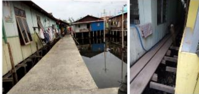
Gambar 9. Kondisi jalan pada lingkungan permukiman (sumber: analisis penulis, 2018)
