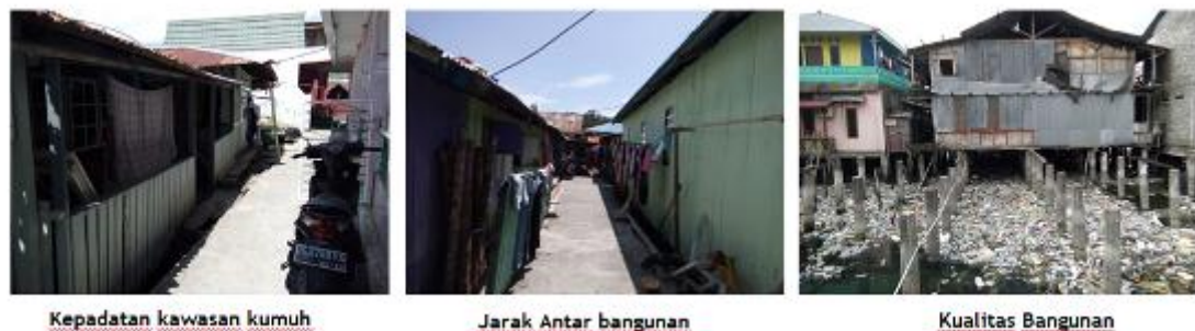
Gambar 2. Permasalahan Kondisi Fisik Bangunan (sumber: analisis Penulis, 2018)
