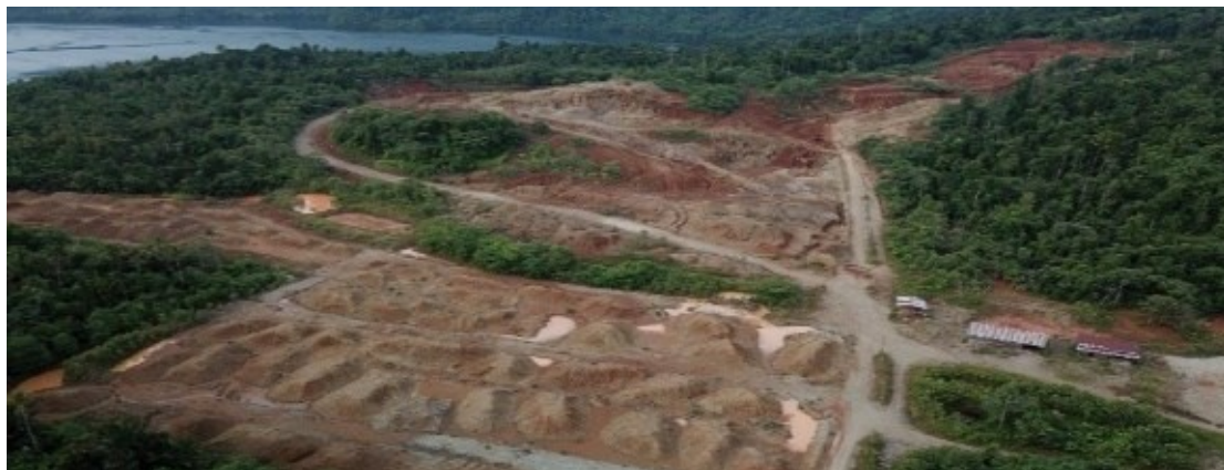
Gambar 6. Kondisi Hutan Saat Ini di Desa Sagea (Sumber: Dokumentasi Peneliti, 2025)
