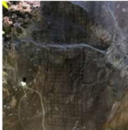
Gambar 5. Kondisi Stasiun Lokasi 2 Tubo
