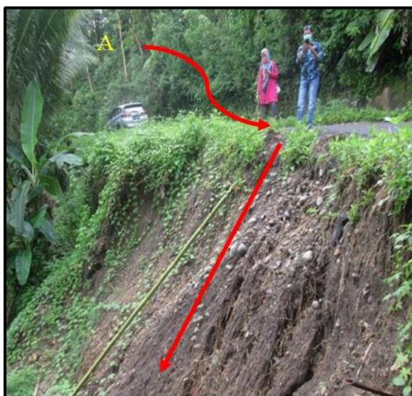
Gambar 3. Foto down slope yang berpotensi longsor kembali, badan jalan sudah terkikis (A)
