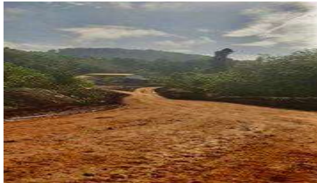
Gambar 6. Area Jalan yang Terlalu Sempit (Dokumentasi Lapang, 2023)
