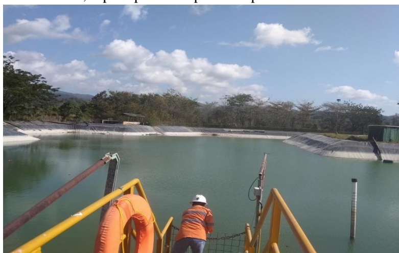
Gambar 1. Kondisi area Kolam Pengumpul Lindi
