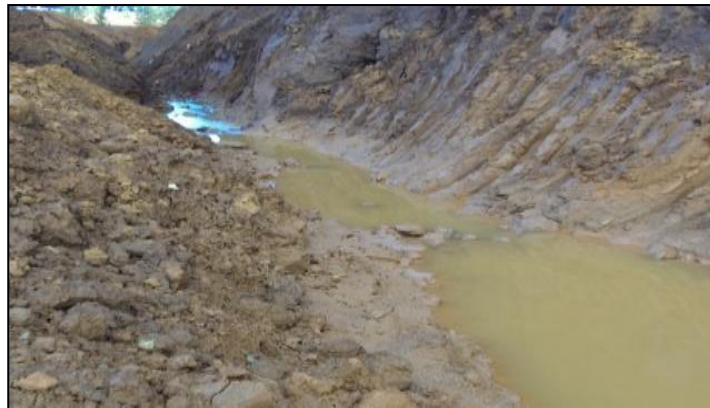
Gambar 5. Saluran Drainase Pit F6
