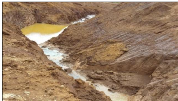
Gambar 3. Saluran Drainase Pit Bunaken Bawah
