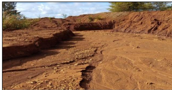
Gambar 7. Saluran Drainase Pit Bunaken Atas
