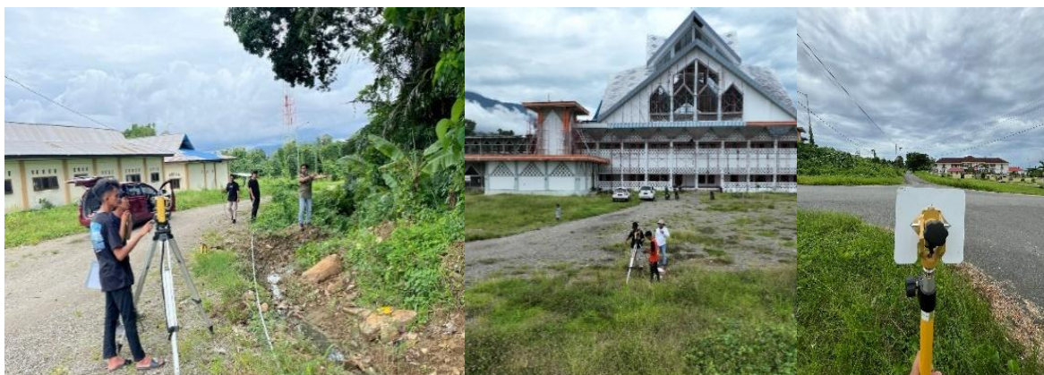
Gambar 1. Proses Pengukuran Topografi Menggunakan Total Station
