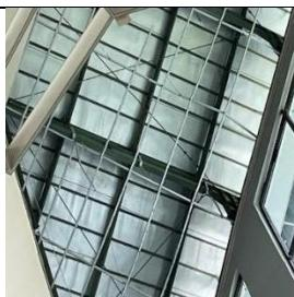
Konstruksi rangka penggantung plafon dengan bahan dan pemasangan yang tidak memadai sangat beresiko terhadap kejatuhan tiba-tiba
