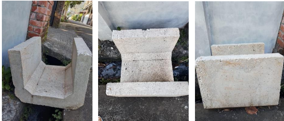
Gambar 3. U-Ditch pracetak ringan menggunakan material pasir batu apung
