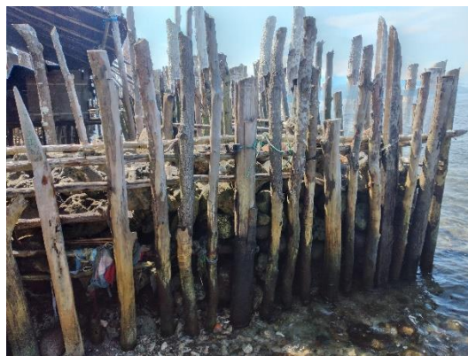
Gambar 3. Photo konstruksi pengaman pantai – rumah penduduk
