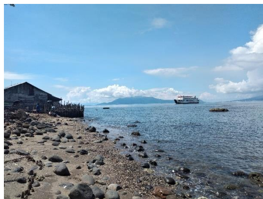
Gambar 4. Photo laju abrasi pantai terhadap rumah penduduk
