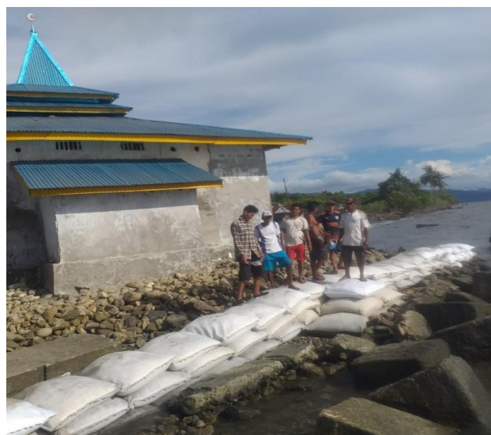
Gambar 4. Photo pemasangan geobag geotextile di Toseho (Suyuti dkk, 2021)
