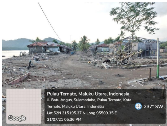
Gambar 3. Photo kerusakan rumah warga saat tahun 2021 lalu
