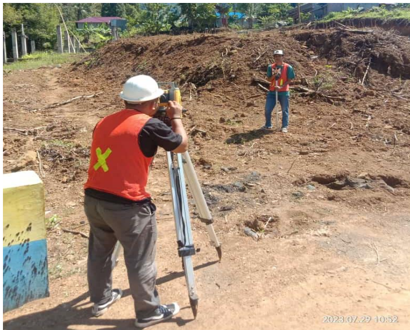
Gambar 1. Pengukuran dengan alat total station
