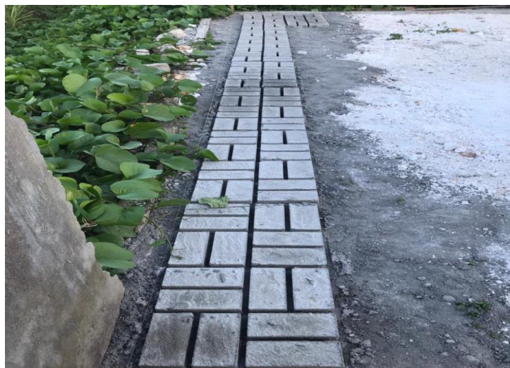
Gambar 5. Pemanfaatan Paving Block Limbah Tailing sebagai Jalan Setapak di SMAN 22 Halsel
