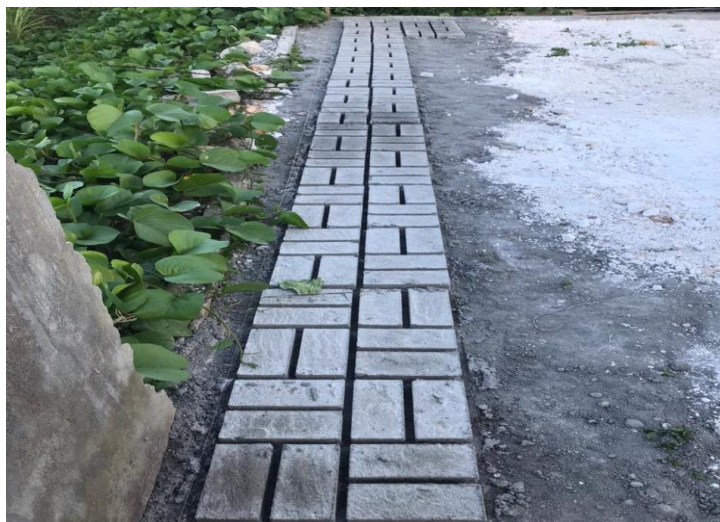
Gambar 5. Pemanfaatan Paving Block Limbah Tailing sebagai Jalan Setapak di SMAN 22 Halsel
