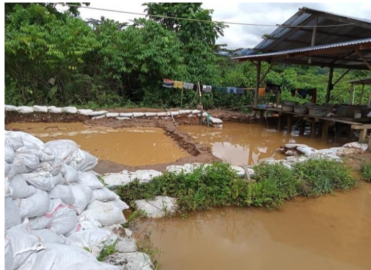
Gambar 5. Pembuatan sediment pond untuk menurunkan kadar TSS
