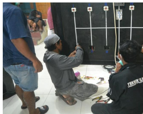
Gambar 4. Pemasangan saklar tunggal dan stop kontak dengan satu lampu
