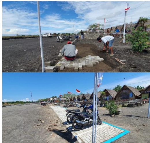
Gambar 3. Pemasangan Paving dan Pembuatan Marka Petak Parkir
