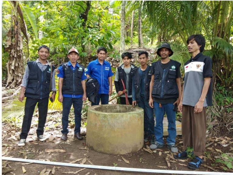
Gambar 3. Pengecekan kondisi sumur
