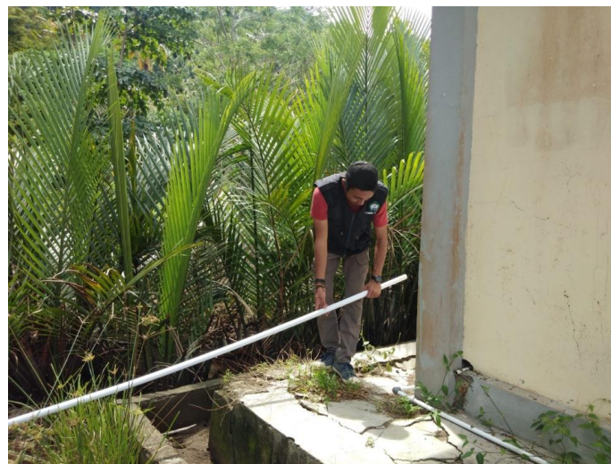
Gambar 5. Proses pemasangan pipa ke rumah warga
