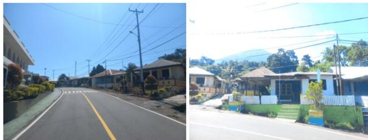
Gambar 2. Kondisi Permukiman Kelurahan Tomalou (Sumber: Dokumentasi Pribadi, 2023)
