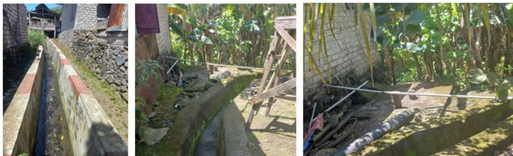
Gambar 6. Drainase lingkungan untuk Limbah Rumah Tangga Grey Water
