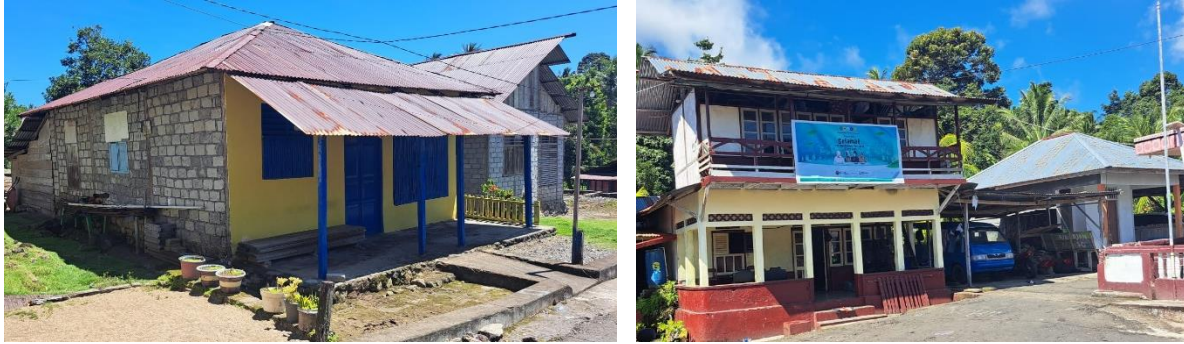
Gambar 5. Kemiringan atap pada Rumah penduduk di Kelurahan Fobaharu
