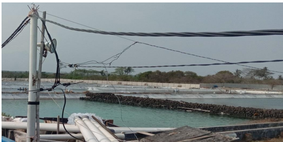
Gambar 1. Tandon pengendapan ( reservoir ) dengan batu trickling
