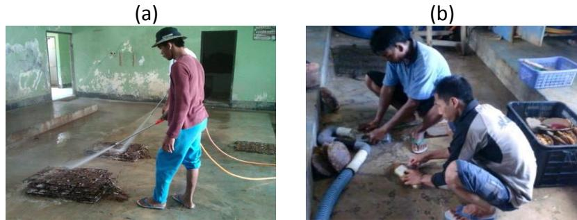
Gambar 4. (a) Menyemprot *Biofouling*, (b) Menyikat *Biofouling*.
