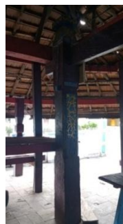
Gambar 9: Tiang Penyangga Utama
