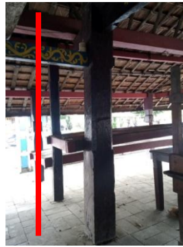
Gambar 20: Garis vertikal bagian tiang penyangga
