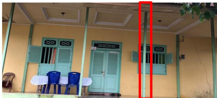
Gambar 2. Tiang Teras Rumah Adat Berbentuk Balok
