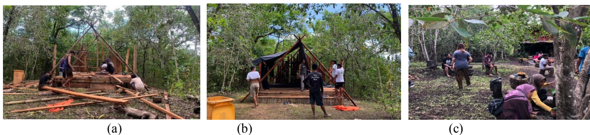
Gambar 6. Pembuatan panggung dan pembersihan di Pulo Tareba, Takome pada Kamis, 08 Agustus 2024
