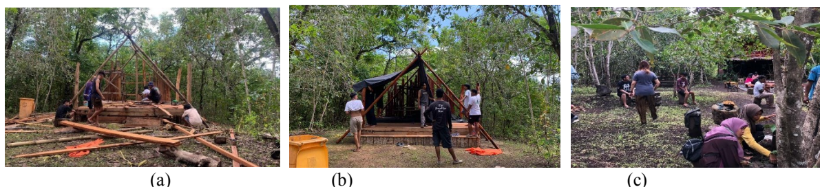
Gambar 6. Pembuatan panggung dan pembersihan di Pulo Tareba, Takome pada Kamis, 08 Agustus 2024
