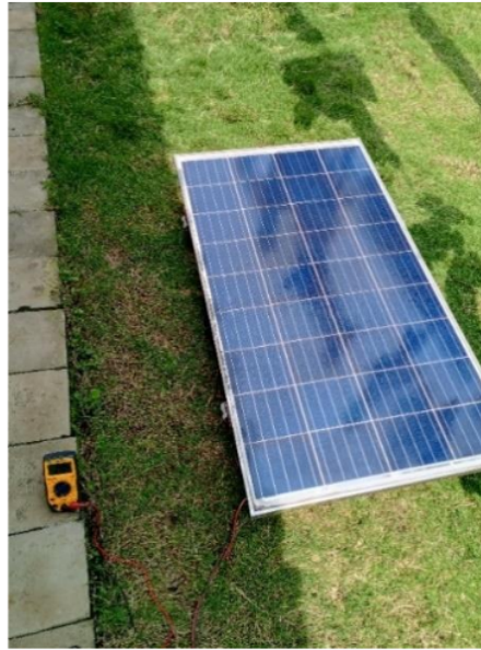
Gambar 11 Pengujian panel surya.
