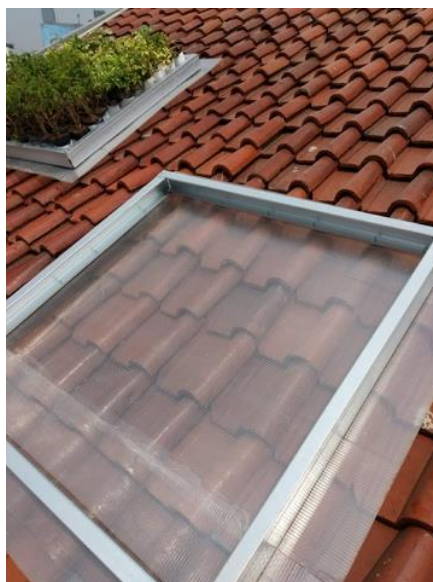
Gambar 5. Benda uji terpasang
