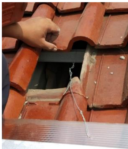
Gambar 4. Pengikatan kabel sling baja pada reng baja ringan
