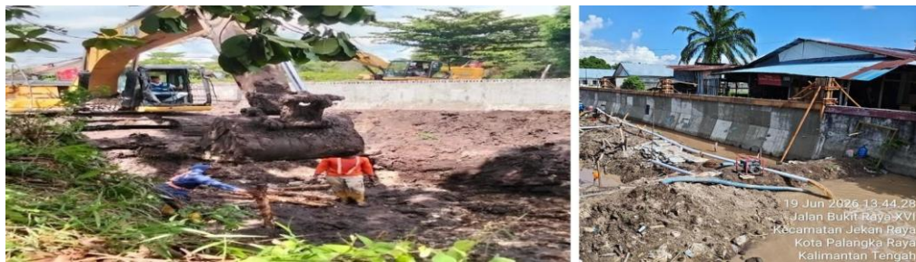
Gambar 2. (a) Pemasangan cerucuk galam dengan bantuan excavator ; (b) pekerjaan dewatering pada area galian. Sumber: Dokumentasi lapangan (2026)
