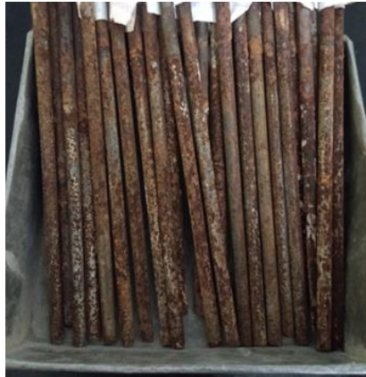
Gambar 4. Korosi Permukaan Baja Tulangan
