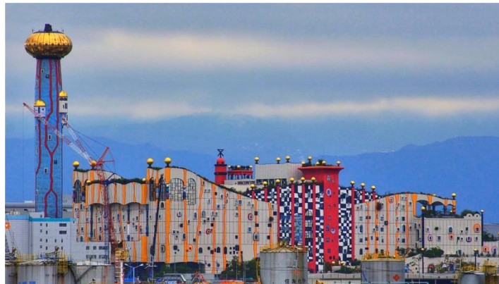
Gambar 4. Maishima Incinerator di Osaka Jepang [58].
