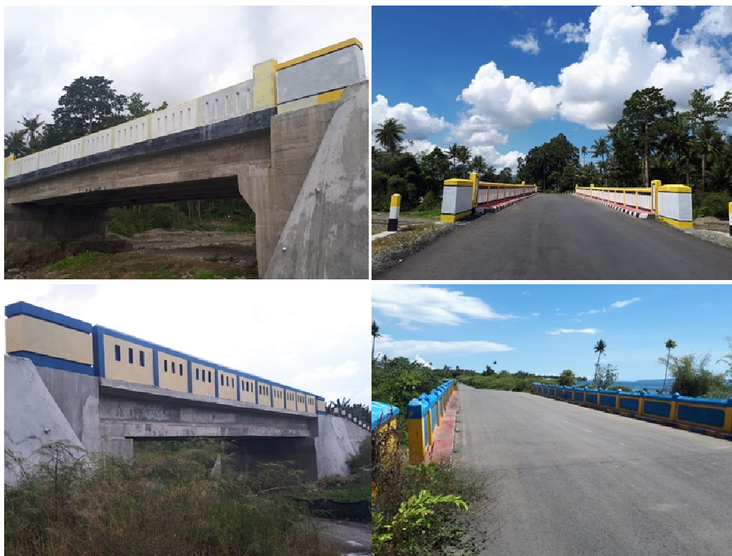
Gambar 5. Jembatan Dengan Struktur Beton
