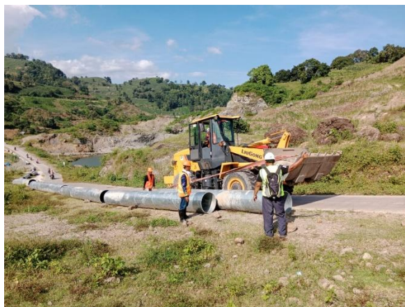
Gambar 1. Gambar Proyek Konstruksi Infrastruktur Jalan
